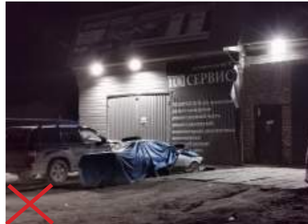
Недопустимо устанавливать светильники (прожекторы) со слепящим эффектом.
